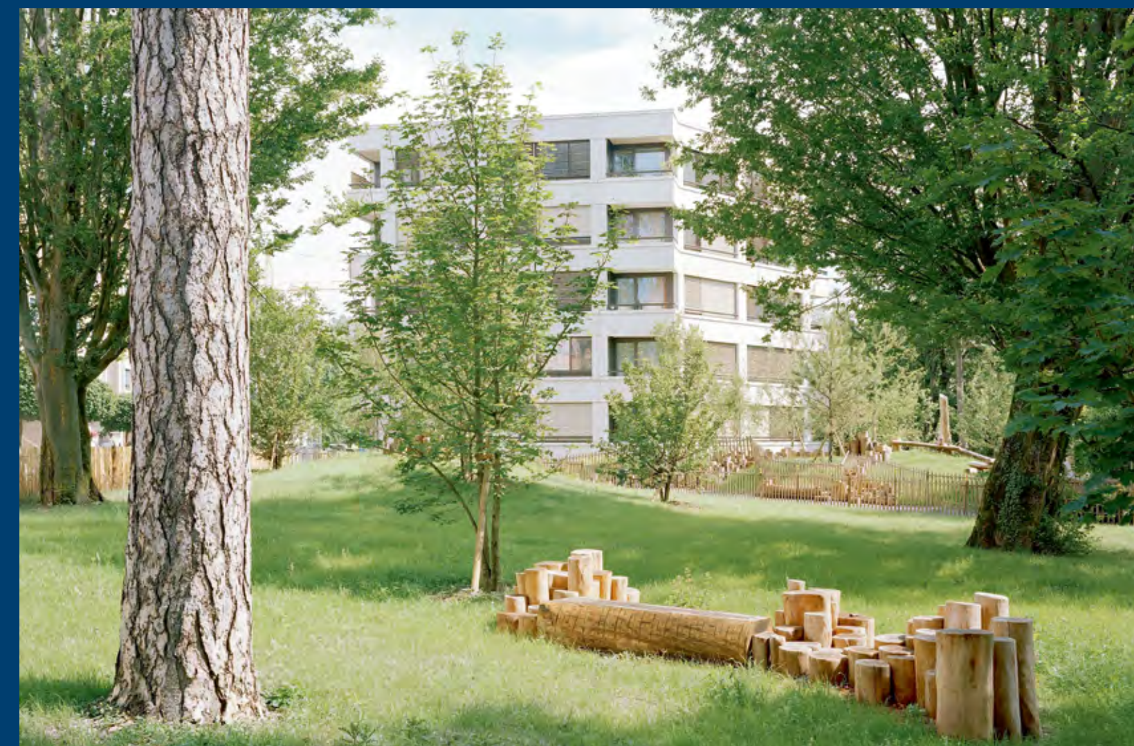
Jacaud Spicher Architectes Associés Wohnbau Avenue Henri Golay, Genf, 2018 Foto: Joël Tettamanti
